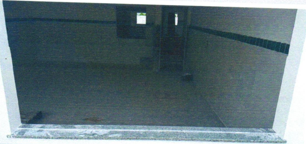
4) INSTALAÇÃO DOS PEITORIS EM GRANITO
